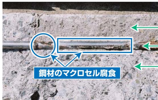
※補修モルタルと既設コンクリートとの境界面で、鋼材の腐食が確認される。
